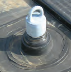
ANCLAJE CON BARRA EN U
