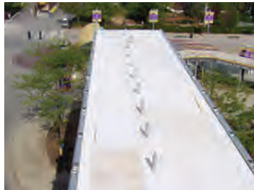
CONSTRUCCIÓN DE TECHOS
